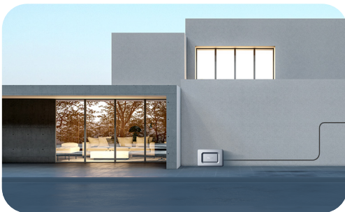
Haus mit installierten Balkonkraftwerken
